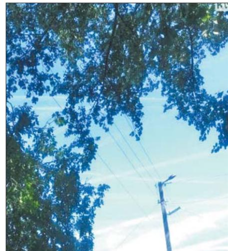
Ветки деревьев-исполинов могут вызвать обрыв проводов или их короткое замыкание.
