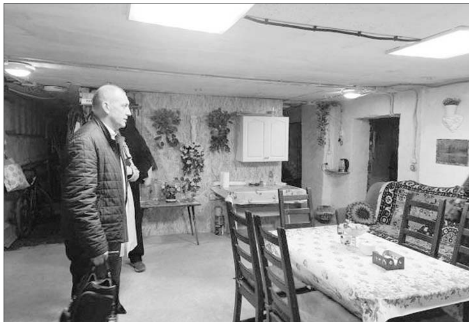
Далеко не все укрытия выглядят как на фото, поскольку многие затоплены водопроводной водой и канализацией.
