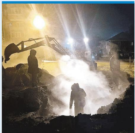
Асфальт провалился из-за прорыва теплотрассы.
