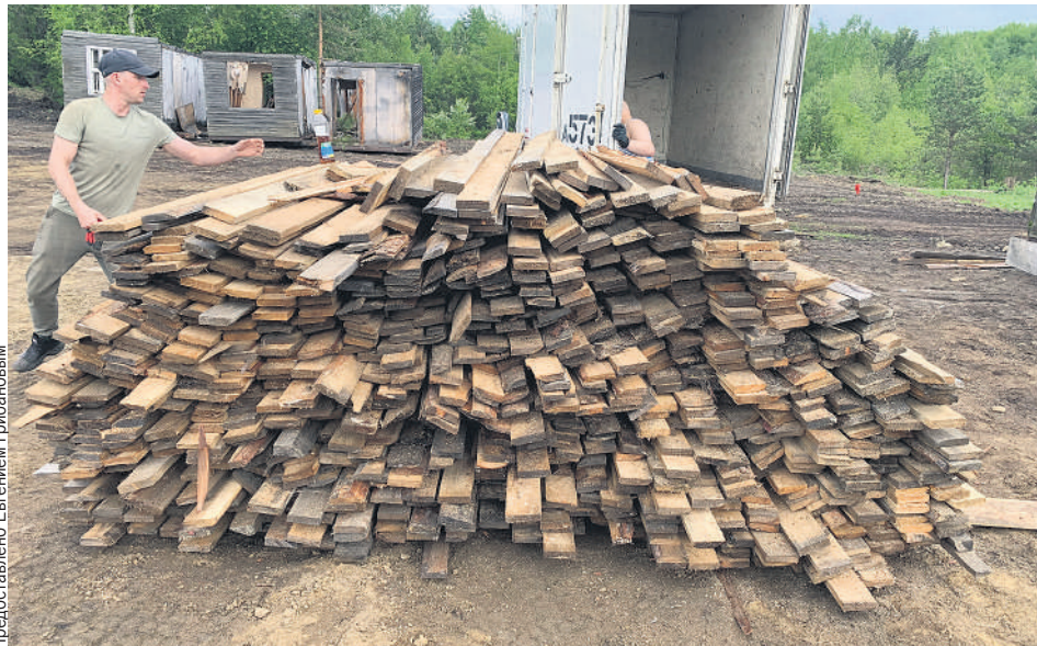
На стройплощадку пока завозятся материалы.
