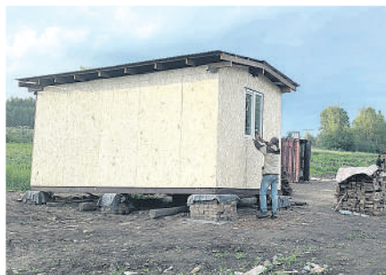
Пока из всех строений готова бытовка для сторожа.
