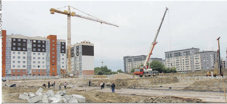
На Сельме рабочие забивают уже больше половины из 2169 свай.
