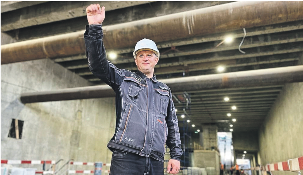
2 августа 2022 года. Руководитель проекта компании-подрядчика по строительству Солнцевского радиуса Максим Донис показывает будущий вестибюль станции «Пыхтино»
