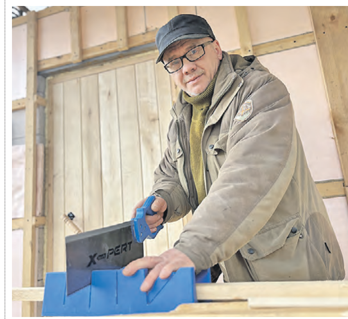
1 мая. Плотник Игорь Куценко занят на строительстве бани. ФОТО: ВАСИЛИСА ЧЕРНЯВСКАЯ
